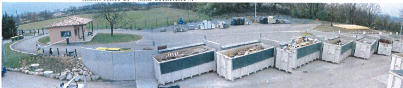
Vue de la déchèterie de Dieupentale
