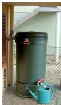
Récupérateur d'eaux pluviales
